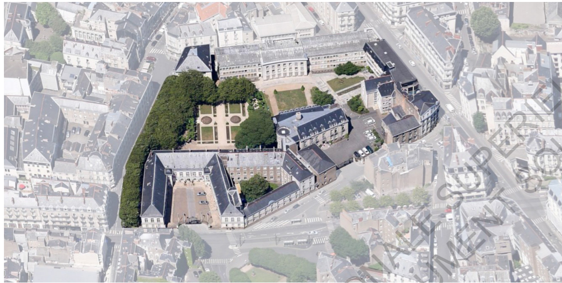
Site de projet: Mairie principale de Nantes
