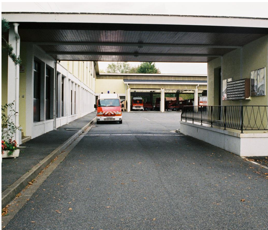
Annexe n°15 : Entrée de la caserne d'Artix
