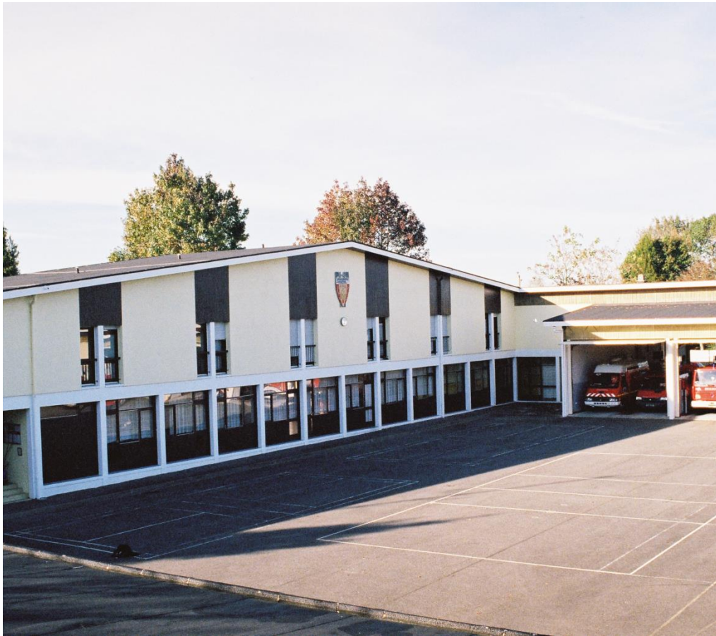
Annexe n°14 : Vue de la caserne d'Artix
