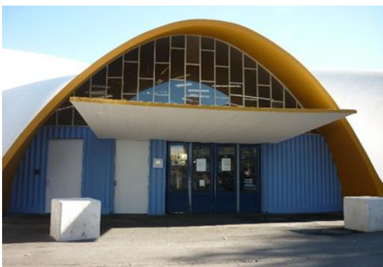
Une des deux entrées du marché couvert.
