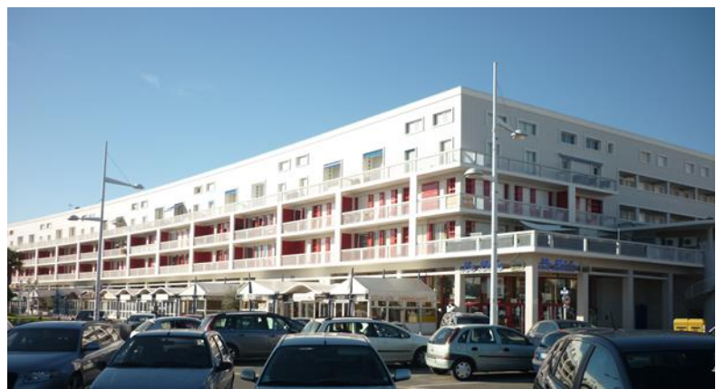
Extrémité Est de l'édifice.2014
