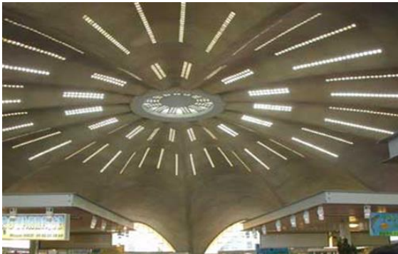
Vue de la voûte depuis l'intérieur.
