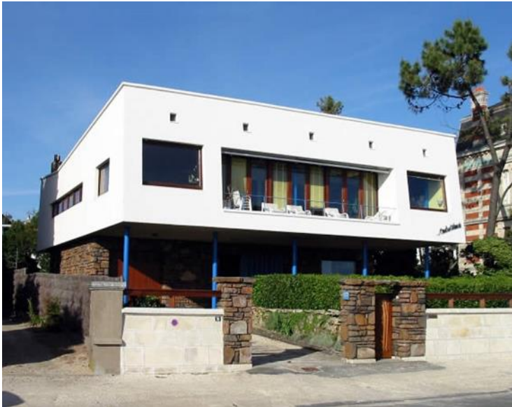
Façade de la villa Ombre Blanche
