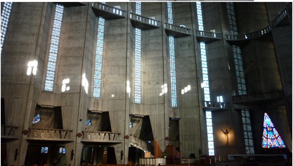
Décor intérieur de l'église laissé en béton brut
