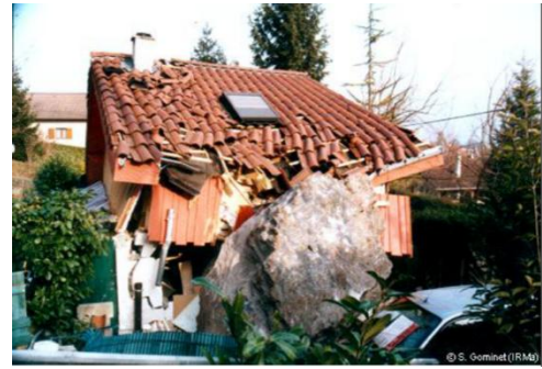
Figure 4: Dégâts provoqués par un éboulement dans la commune de Lumbin en 2011. Source : IRMa
