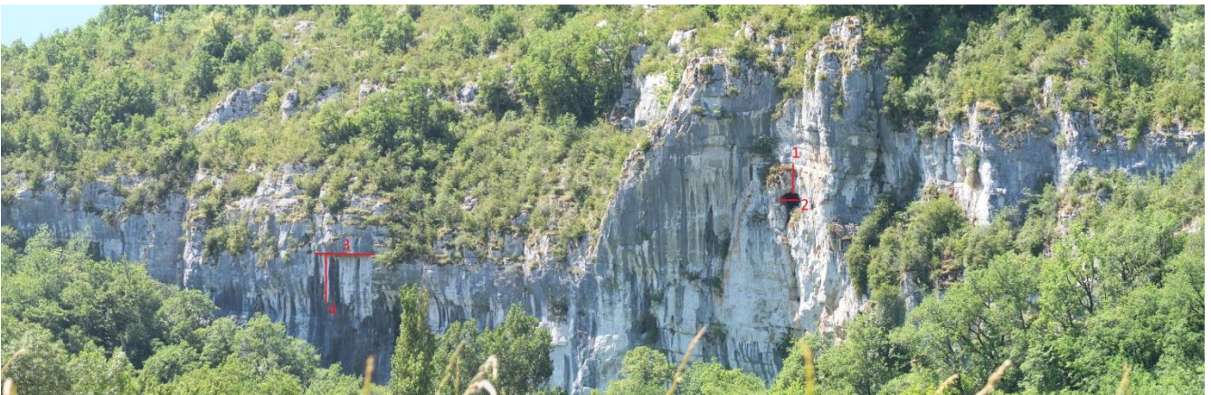
Figure 5 : exemple des prises de mesures horizontales et verticales pour l'étalonnage
