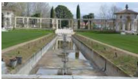
La pergola en travaux (35), photographie personnelle
