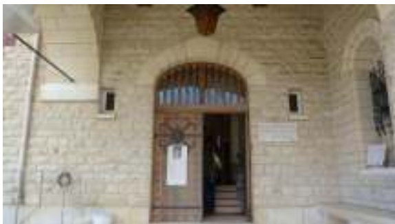
L'entrée de la villa (16), photographie personnelle
