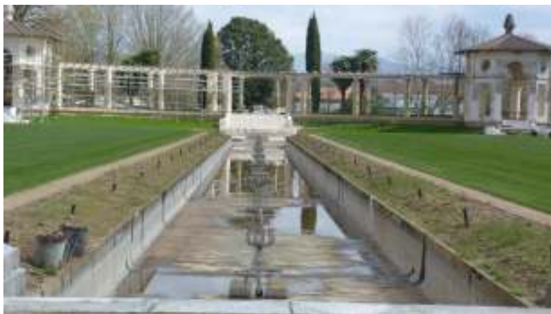
La restauration du grand canal et de la pergola (49), photographie personnelle
