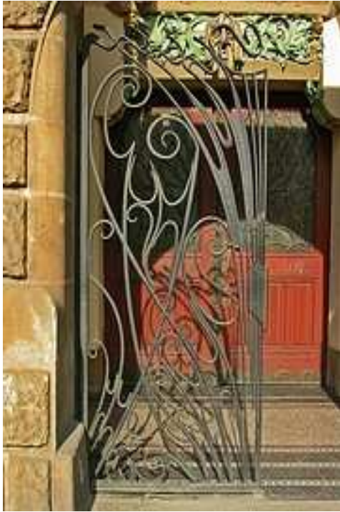
Figure 2.45 : Kamil Hilbert, grille d'entrée et décor art nouveau de la maison numéro 23426 du Quai Mazaryk, 1904, Prague
