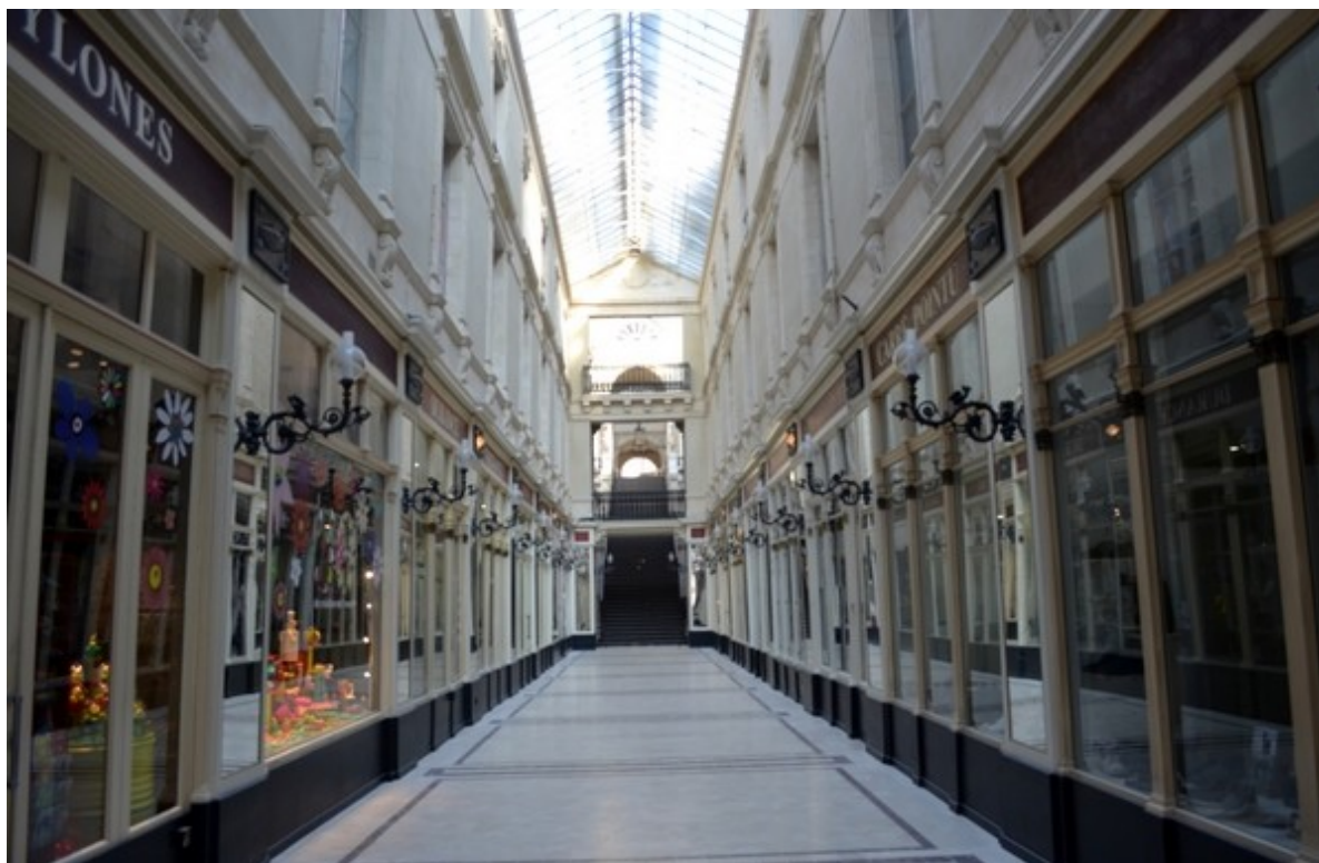
Illustration 7: Galerie basse, dite galerie de la Fosse, vue de l'entrée et sur le passage. (Source : CdA)
