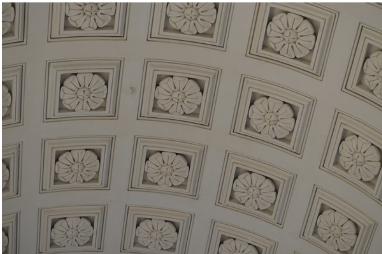
Illustration 34: Plafond à caissons d'une partie de la galerie Santeuil. (Source : CdA)
