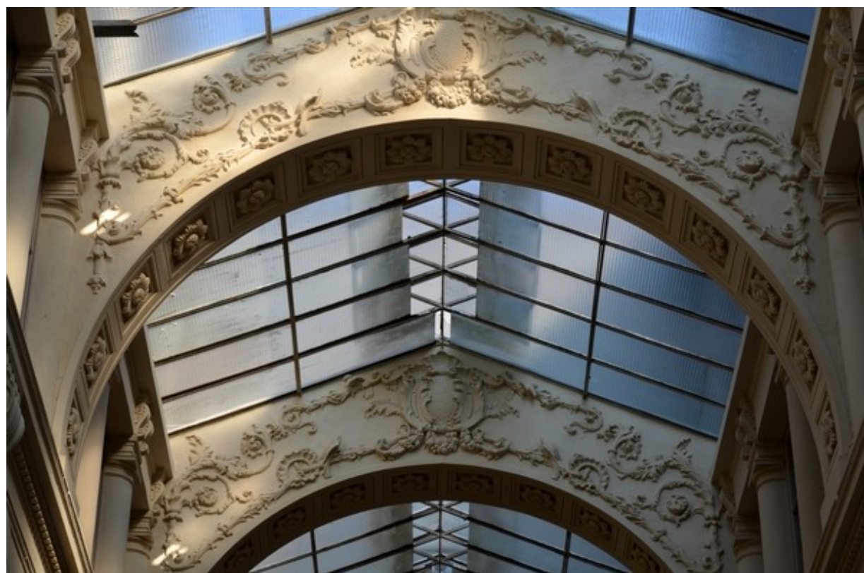
Illustration 12: Verrière de la galerie Santeuil, divisée par une succession d'arcs doubleaux. (Source : CdA)
