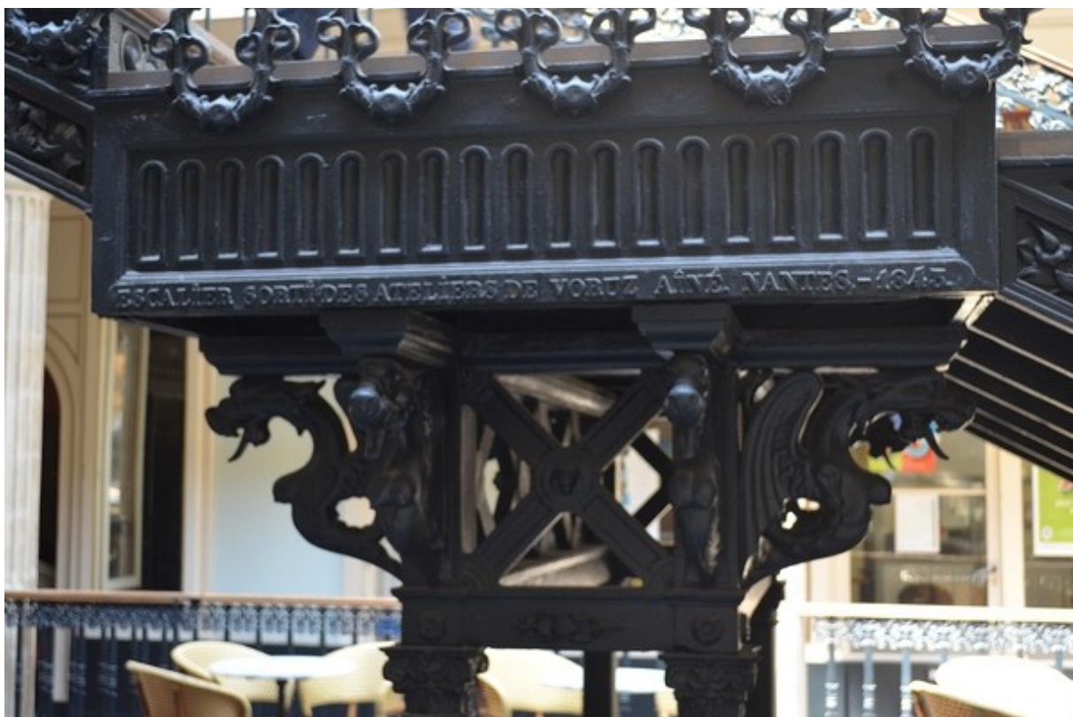
Illustration 15: Palier central de l'escalier, sous lequel les ferronneries sont mentionnées. (Source : CdA)
