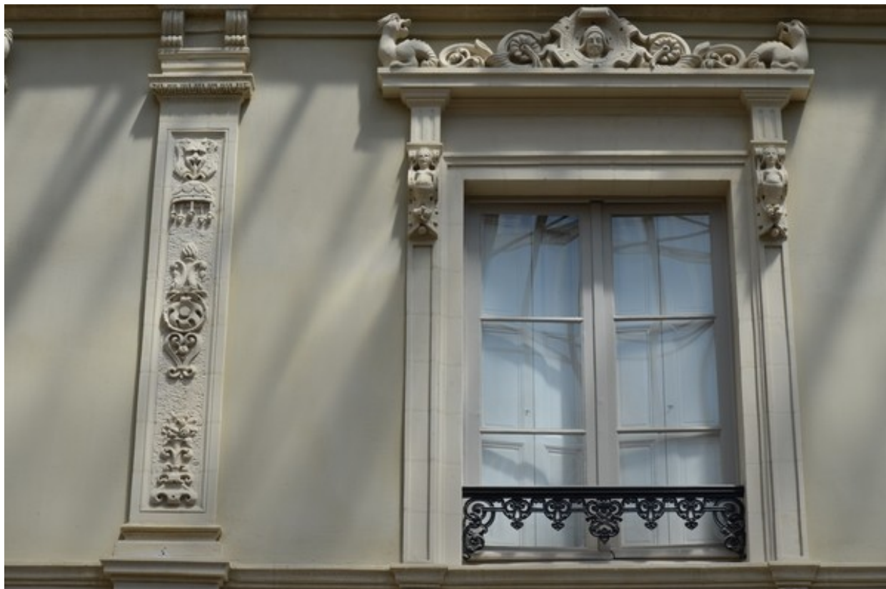
Illustration 33: Fenêtre d'un appartement de la galerie des statues. (Source : CdA)
