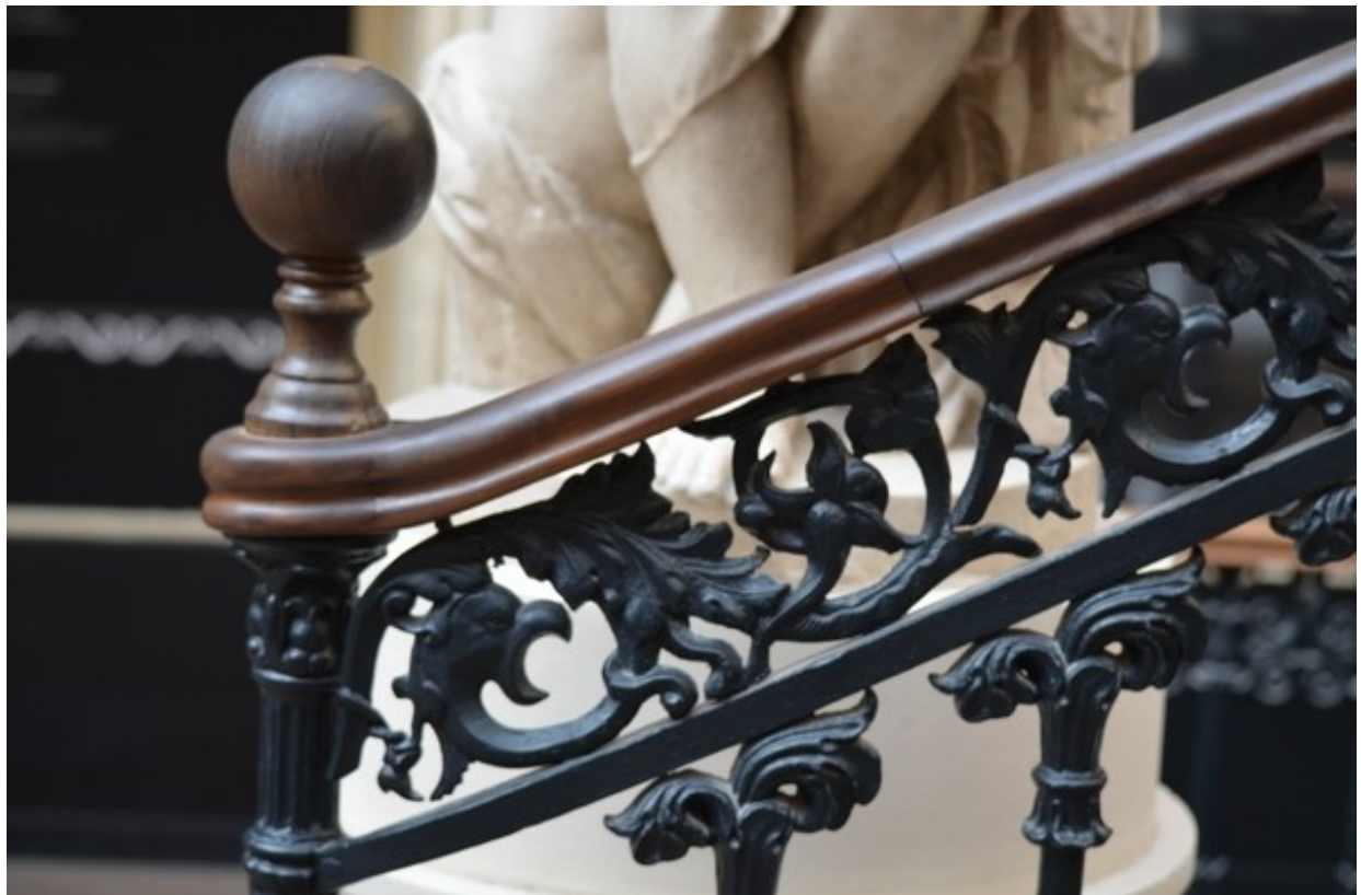
Illustration 17: Rampe de l'escalier, en fer et en bois. (Source : CdA)
