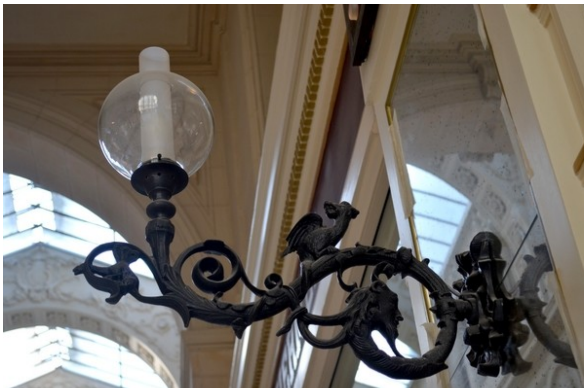
Illustration 18: Bec de gaz fixé sur un miroir. (Source : CdA)
