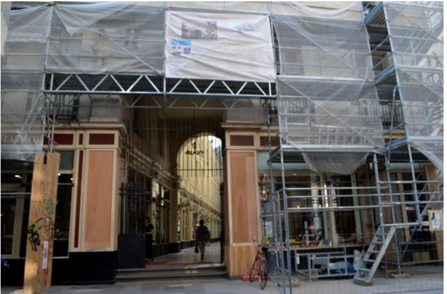
Illustration 40: Entrée de la galerie de la Fosse, en travaux. (Source : CdA)
