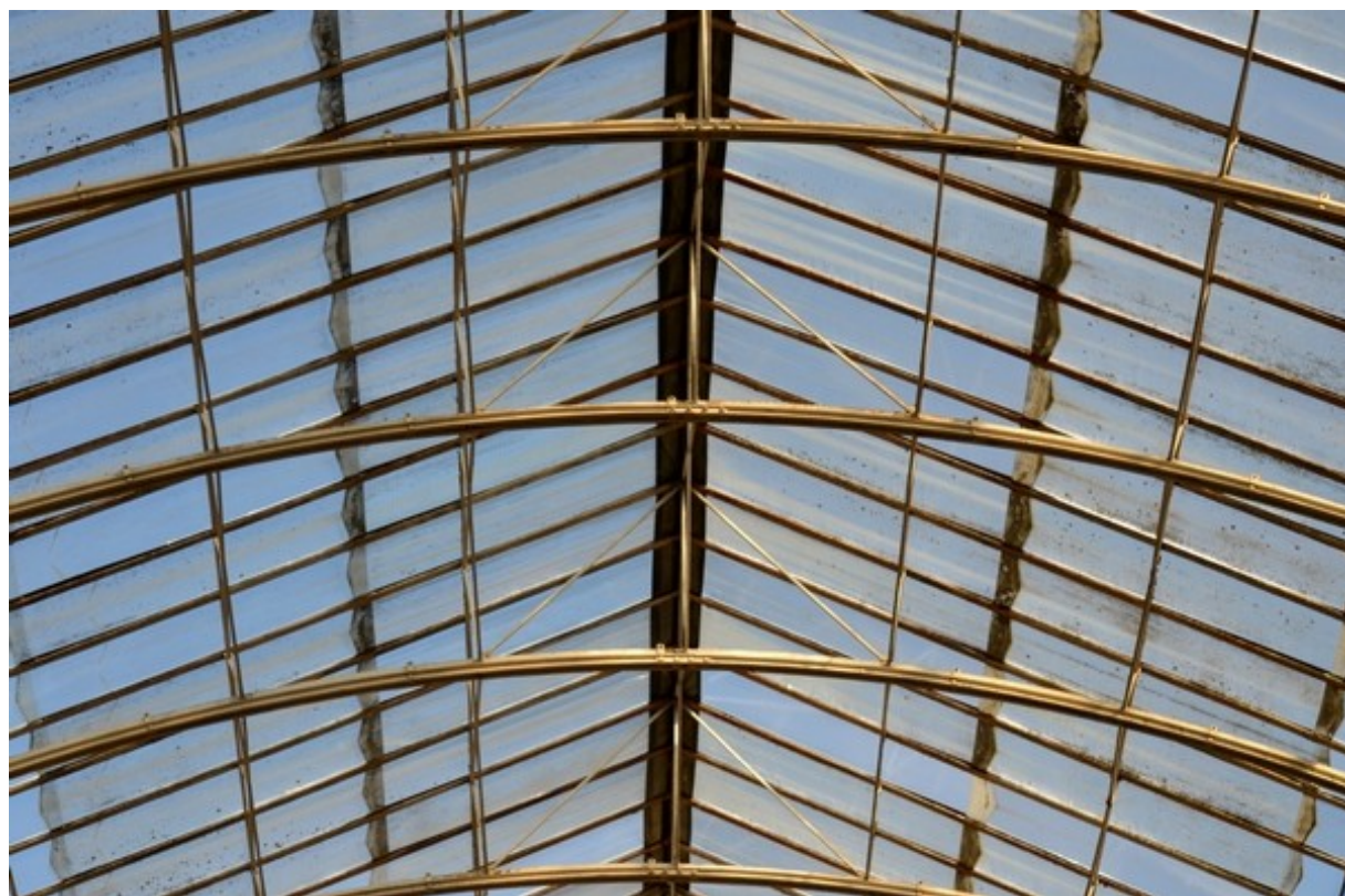
Illustration 11: Structure de fer de la verrière. (Source : CdA)
