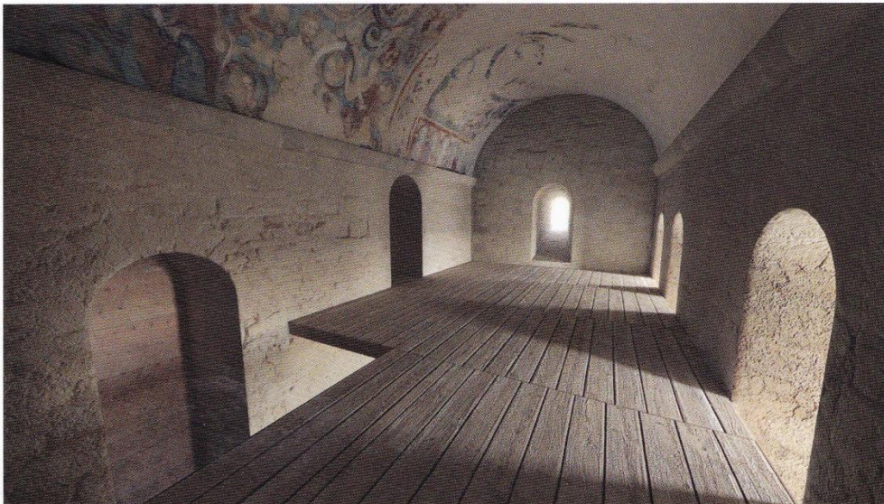
Fig. 8. État de la chapelle entre le xv^e et le xviii^e siècle. La pose d'un plancher la sépare en deux niveaux. Vue de l'étage. La hauteur permet de se tenir debout, l'éclairage est suffisant et rend la pièce tout à fait utilisable.
