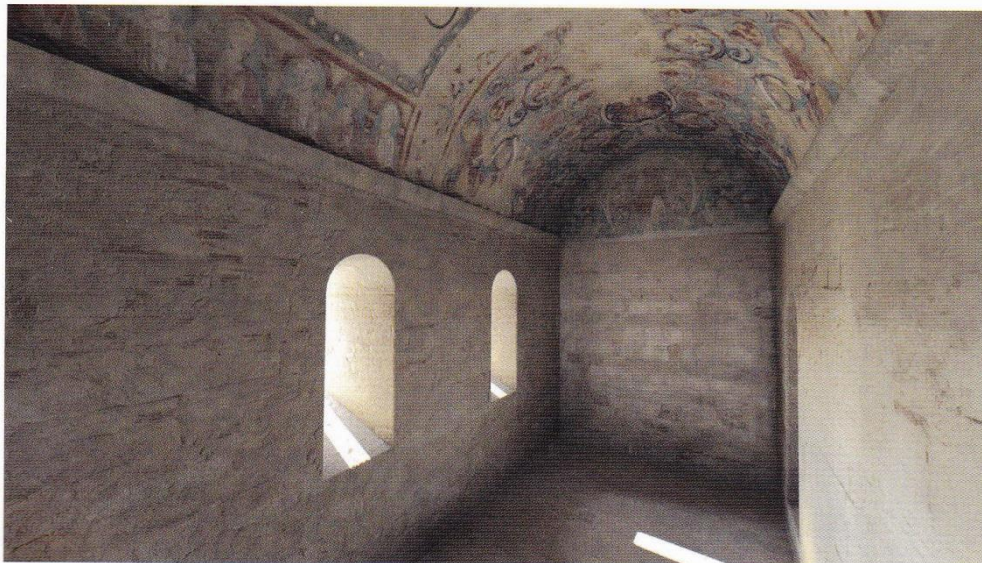
Fig. 11. Vue du côté ouest. La scène de David ainsi que la partie sud de la voûte ont retrouvé une partie de leur décor.
