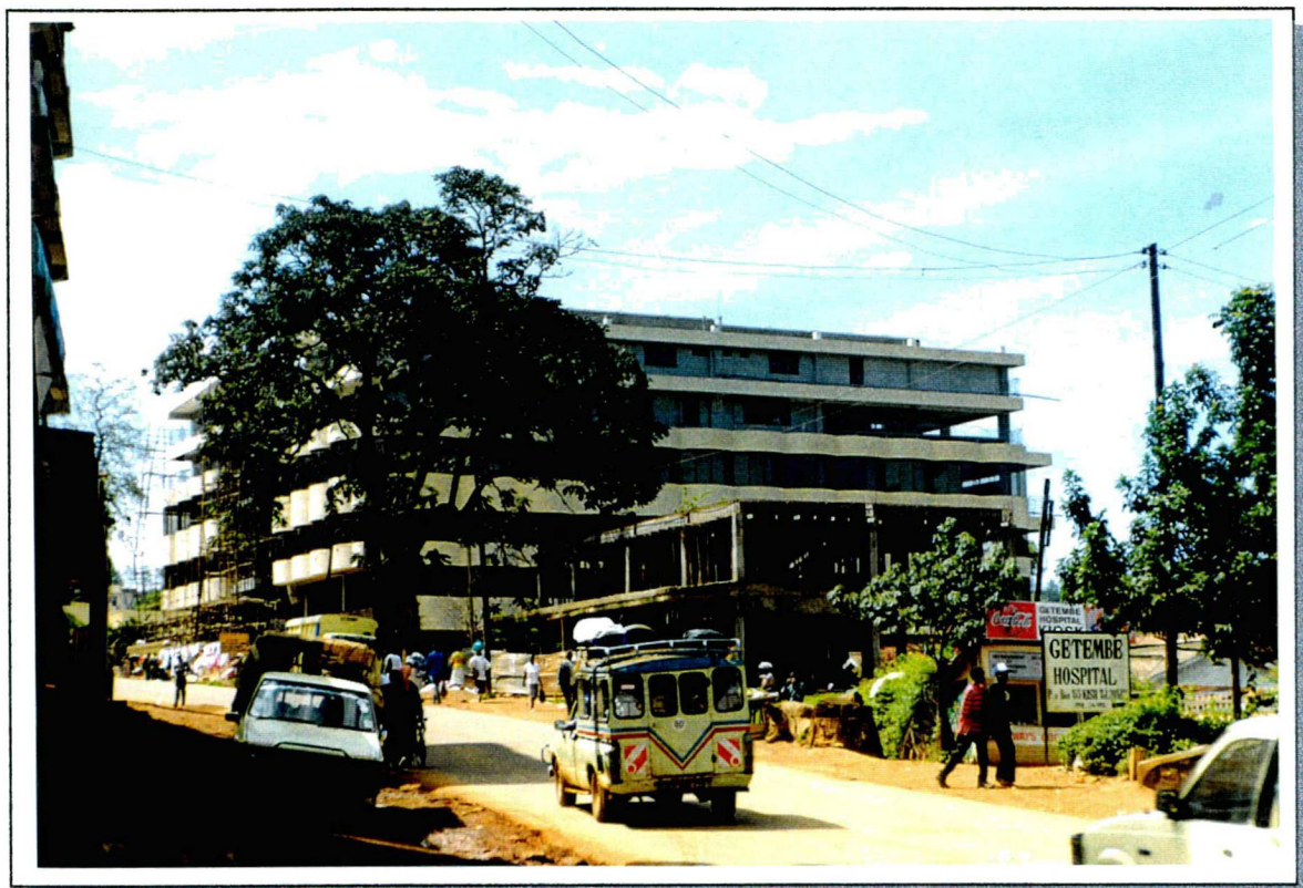
Photo 16 : Construction d'un nouvel immeuble dans le centre.
