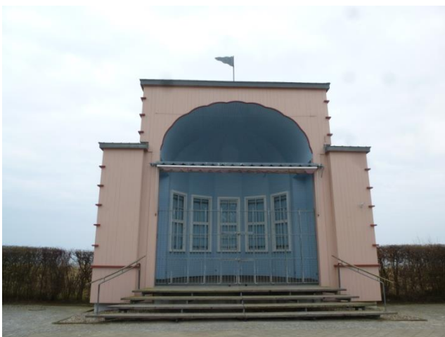
Photographie 25 : Kiosque de la ville balnéaire de Bansin, Cliché de l'auteur, 2015
