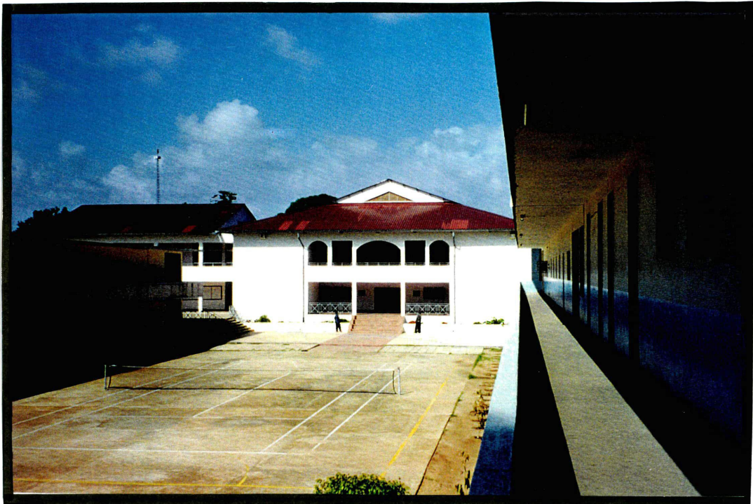
Photographie n° 7. Shaaban Roberts (Upanga) : au fond, les nouveaux bâtiments. De part et d'autre, le corps des anciens bâtiments.
