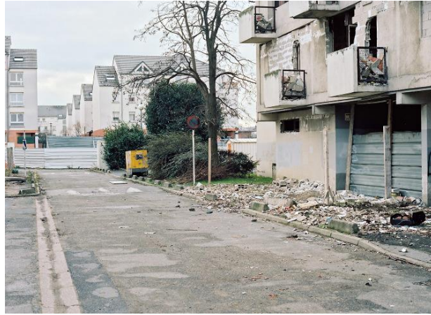
Figure 22: Illustration de la reconstruction-démolition de la cité Pierre Montillet au Blanc-Mesnil, le 21 janvier 2011 63
