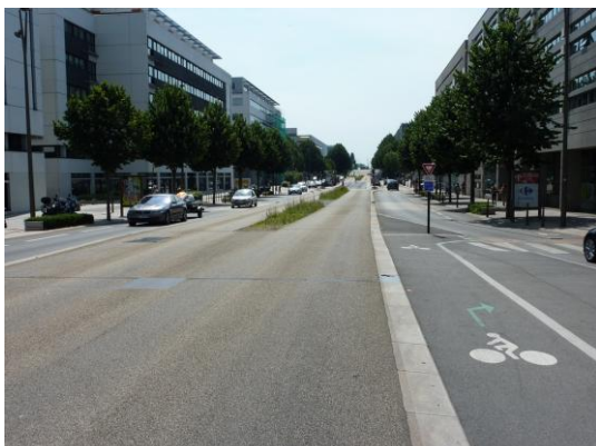
Enrobé hydro-décapé d'origine, utilisé pour le TCSP sur l'intégralité de l'itinéraire (hors station)
