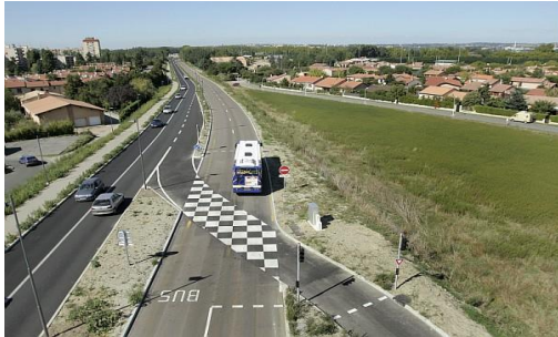
Séparateur infranchissable à bordures hautes
