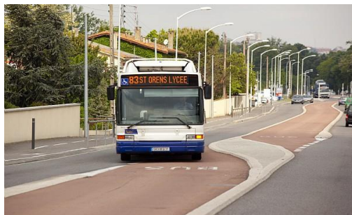
Séparateur franchissable à bordures inclinées
