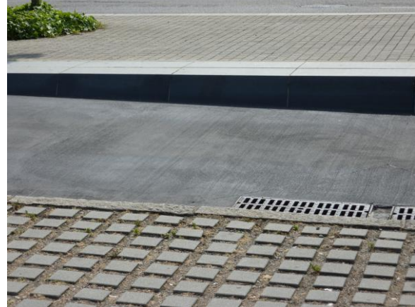
Détail du BCMC en station
