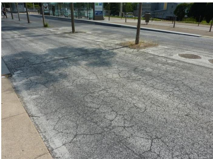
Certaines parties de la plateforme faisant la jonction entre le revêtement de station en BCMC et la plateforme de circulation du Busway, en enrobé hydro décapé, présente du faïençage sans conséquences sur le confort de circulation.
