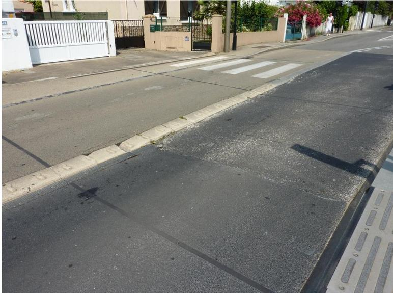
Une partie de la bordure dégradée séparant la voirie du site propre (ici à sens unique) à l'arrêt Chapeau Verni en direction de Porte de Vertou. Le phénomène est dû au passage de la remorque des véhicules articulés du Busway. La manœuvre en sortie de rue à 90° vers la gauche rend difficile l'évitement de circulation sur la bordure elle-même.
