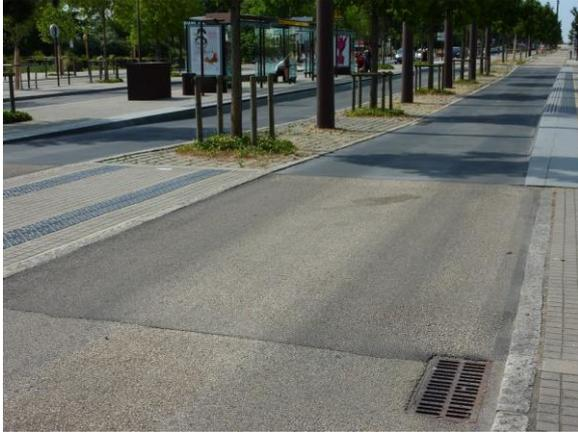
*Insertion en station entre le revêtement hydro-décapé du site propre, la jonction en enrobé percolé et le béton de remplacement en station*
