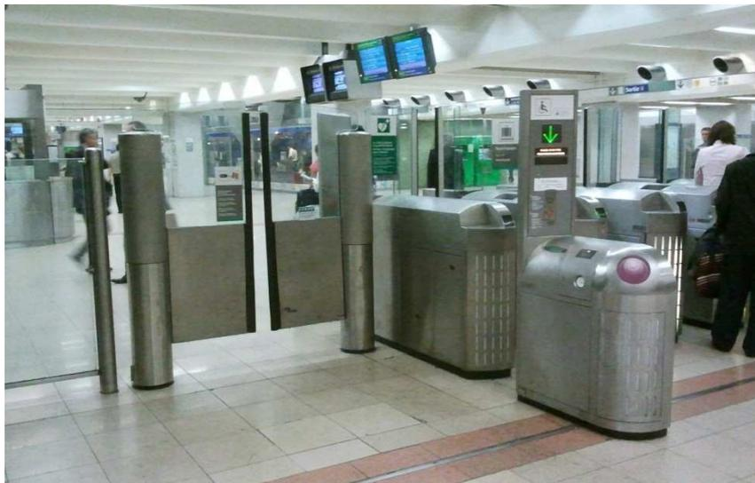
Figure 10 - Un valideur à passage élargi motorisé.
