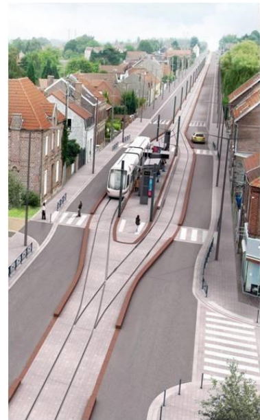
Figure aa : Voie d'évitement en station à Valenciennes (Source : http://www.siturv.fr )
