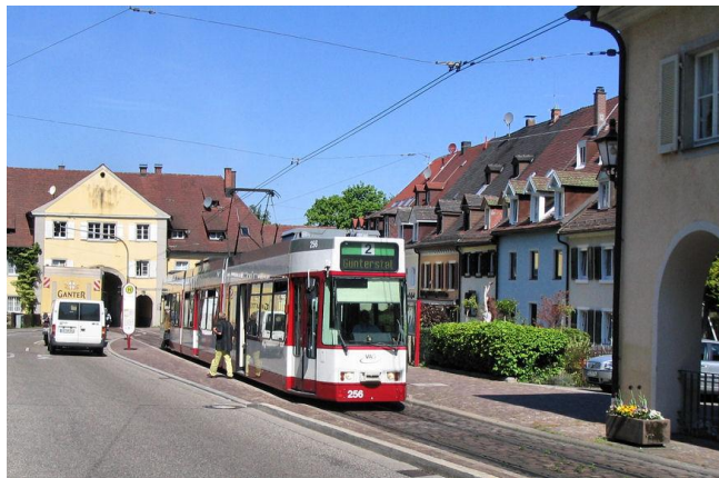
Tramway de Freiburg en voie unique, Allemagne
