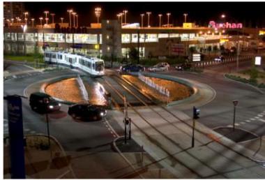
Figure pp : Tramway de Nantes traversant un giratoire
