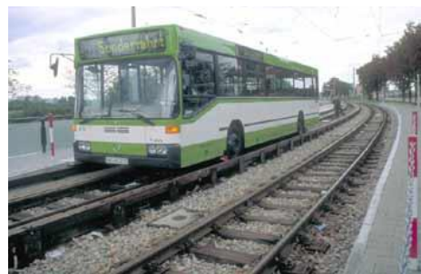
Figure h : Le "O-Bahn" à Mannheim, en tronc commun avec le tramway (Source : http://www.bhns.fr )
