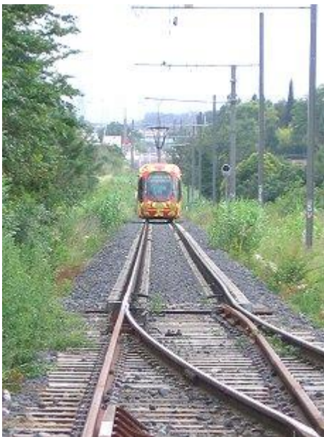
Figure y : Tramway de Montpellier en voie unique
