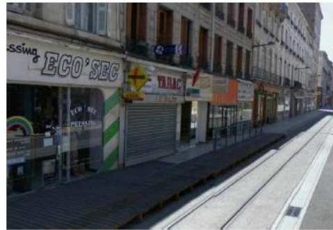
Figure 55 : Cheminement piéton servant de quai à Saint-Etienne
