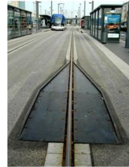
Figure o : Passage du mode non-guidé au mode guidé du TVR (Source : Sophie Morhun, La renaissance du tramway )
