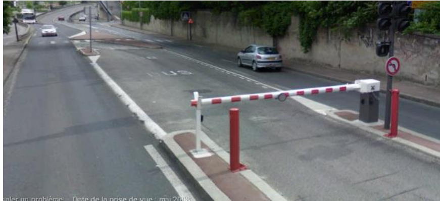
Figure mm : Entrée du site propre bus protégée par une barrière (Source : Street View)
