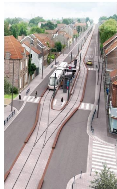
Figure aa : Voie d'évitement en station à Valenciennes (Source : http://www.siturv.fr )
