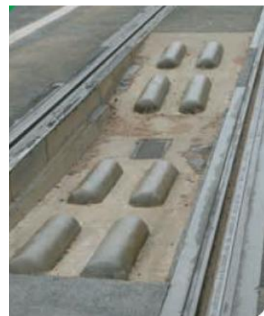
Figure u : Ecluse (Source : STIB)
