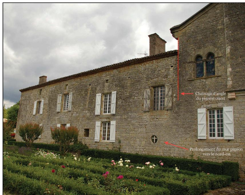
Figure 48 : Château de Montayral - Prolongement du mur pignon de la grande salle par un corps de logis en retour d'équerre (vue de l'ouest). Cliché et DAO : F. Boisserie
