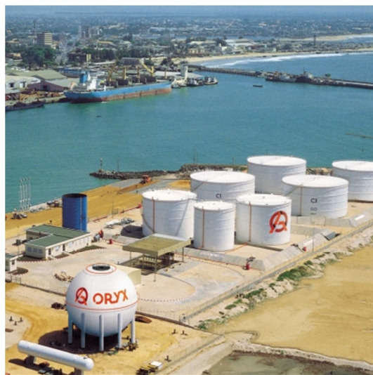
Figure n°2 : Vue partielle du terminal d'OBSA
