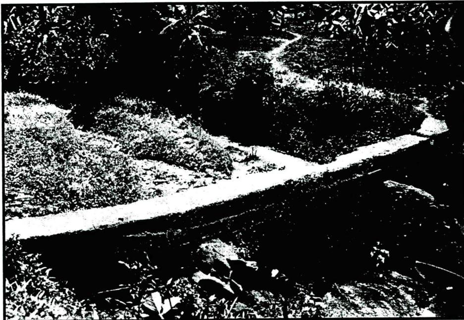
Photos 3, et 4 : Deux types de prises d'eau à Mwasi South : en haut, la prise d'eau traditionnelle du canal Sambuta (à gauche), branché sur la rivière Mrusunga (à droite); au-dessous, un barrage moderne grâce auquel une partie de l'eau de la rivière Kyoyo est dirigée vers le canal Kyoyo (le surplus est évacué, en aval, dans la rivière Rau).
