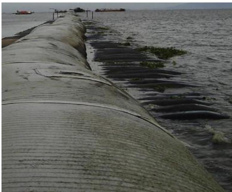
Figure 17 Accumulation de la plage après installation du géotextile sur une plage de Malaisie à l'est de Terengganu (source : LEE *et al*: II.G.n)
