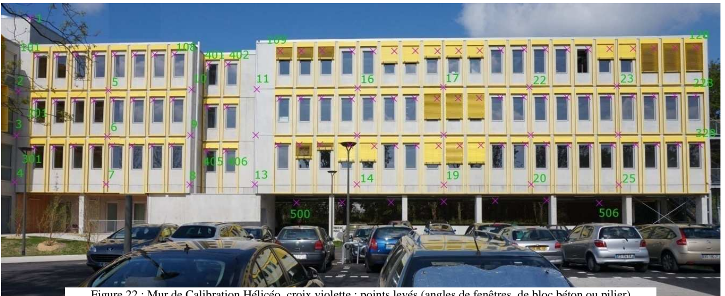
Figure 22 : Mur de Calibration Hélicéo, croix violette : points levés (angles de fenêtres, de bloc béton ou pilier)
