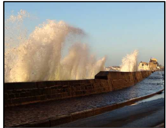
Illustration 2 : Franchissement de la digue par les vagues à St Malo (Source : www.st-malo.com )
