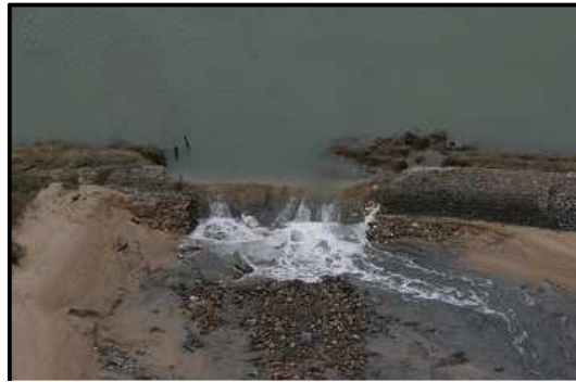
Illustration 4 : Rupture de digue à Guérande lors de la tempête Xynthia (Source : DREAL Pays de la Loire)
