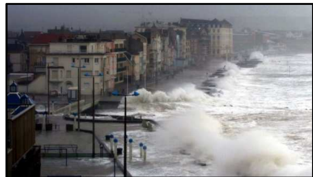
Illustration 3 : Débordement des eaux de mer à Wimereux en 2007 (Source : France3 régions, Nord Pas-de-Calais)
