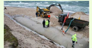
Pose de géotextile sur la plage
