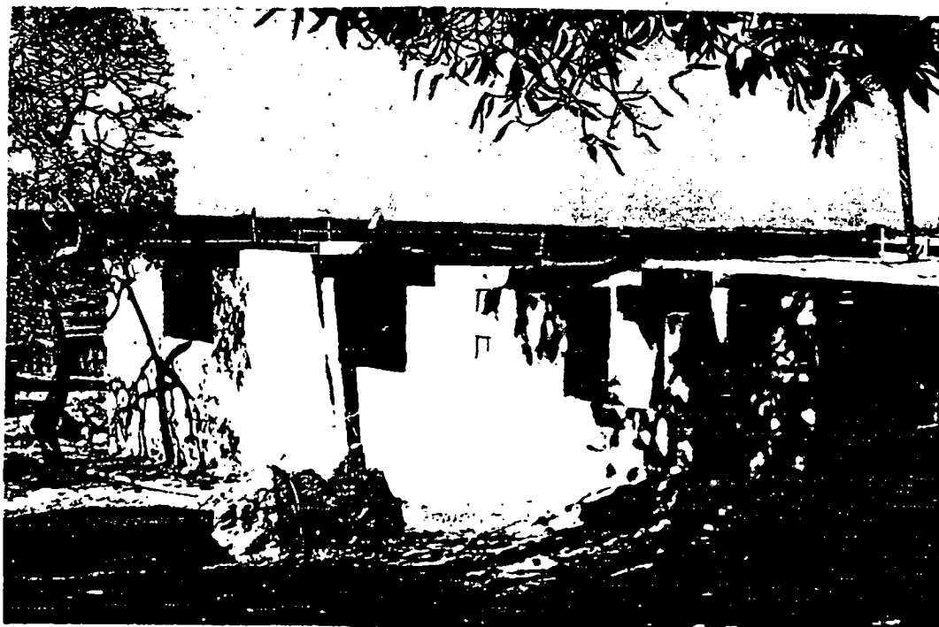
Photo n°30 Maison en construction dans le secteur « informel » de Kigamboni
