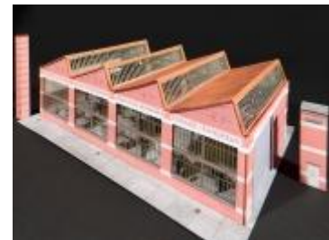
Illustration 8 : Toiture en Sheds
