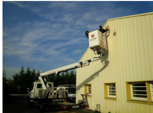
Figure 24 : Installation de la station de campagne RUAU contre le bardage d'un bâtiment municipal de la commune de Ruaudin à l'aide d'un camion nacelle. La station météorologique (PTU300) est montée sur le mât de support de l'antenne.
