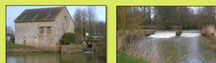
Moulin, barrage et déversoir au site de Hauterive
