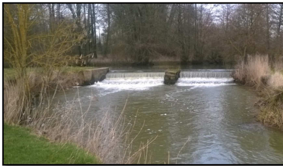
Figure 13: Déversoir et bras de décharge. Site du moulin de Hauterive
