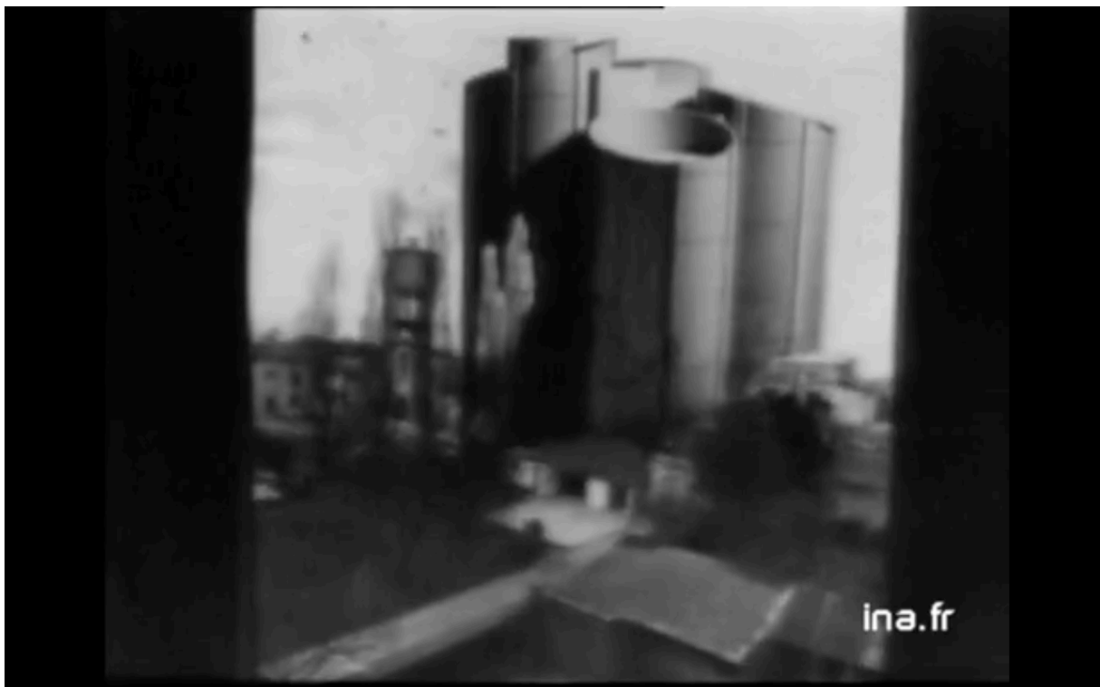
Document 5: Le château d'eau de Saint-Maur construit en 1975 78
