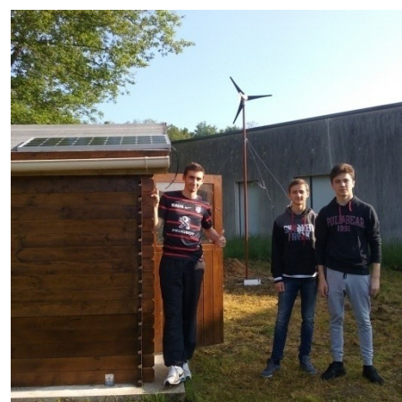
Figure 15 : Projet 3 production hybride d'électricité en site isolé, installation du panneau solaire
