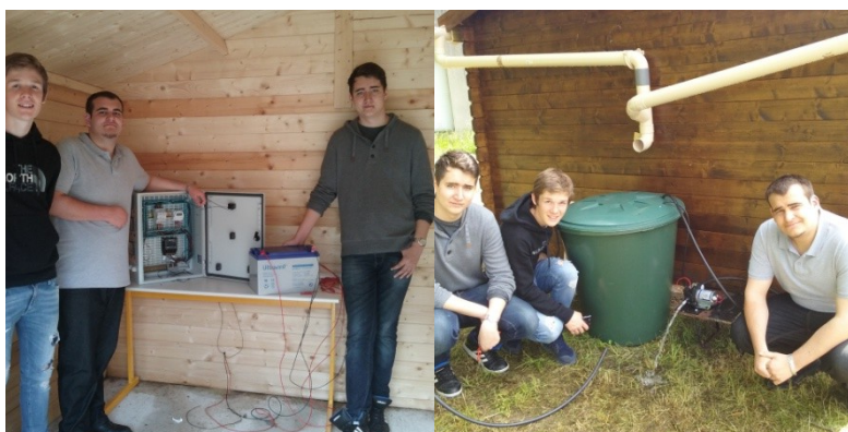
Figure 14 : Projet 7 pompage et arrosage programmés-Fonctionnement de la pompe
