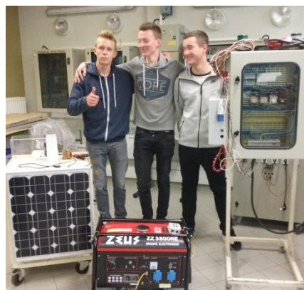
Figure 13 : Projet 6 optimisation de la facture énergétique, prototype
