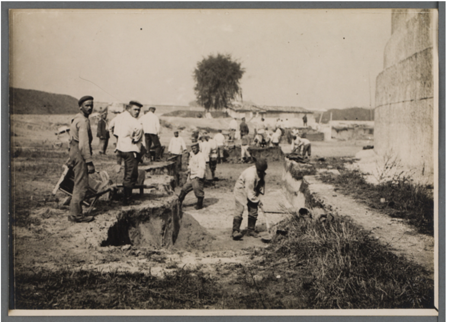
Annexe 4c : Stade de Lyon. Camp de prisonnier. Instantané pris sur le chantier.
