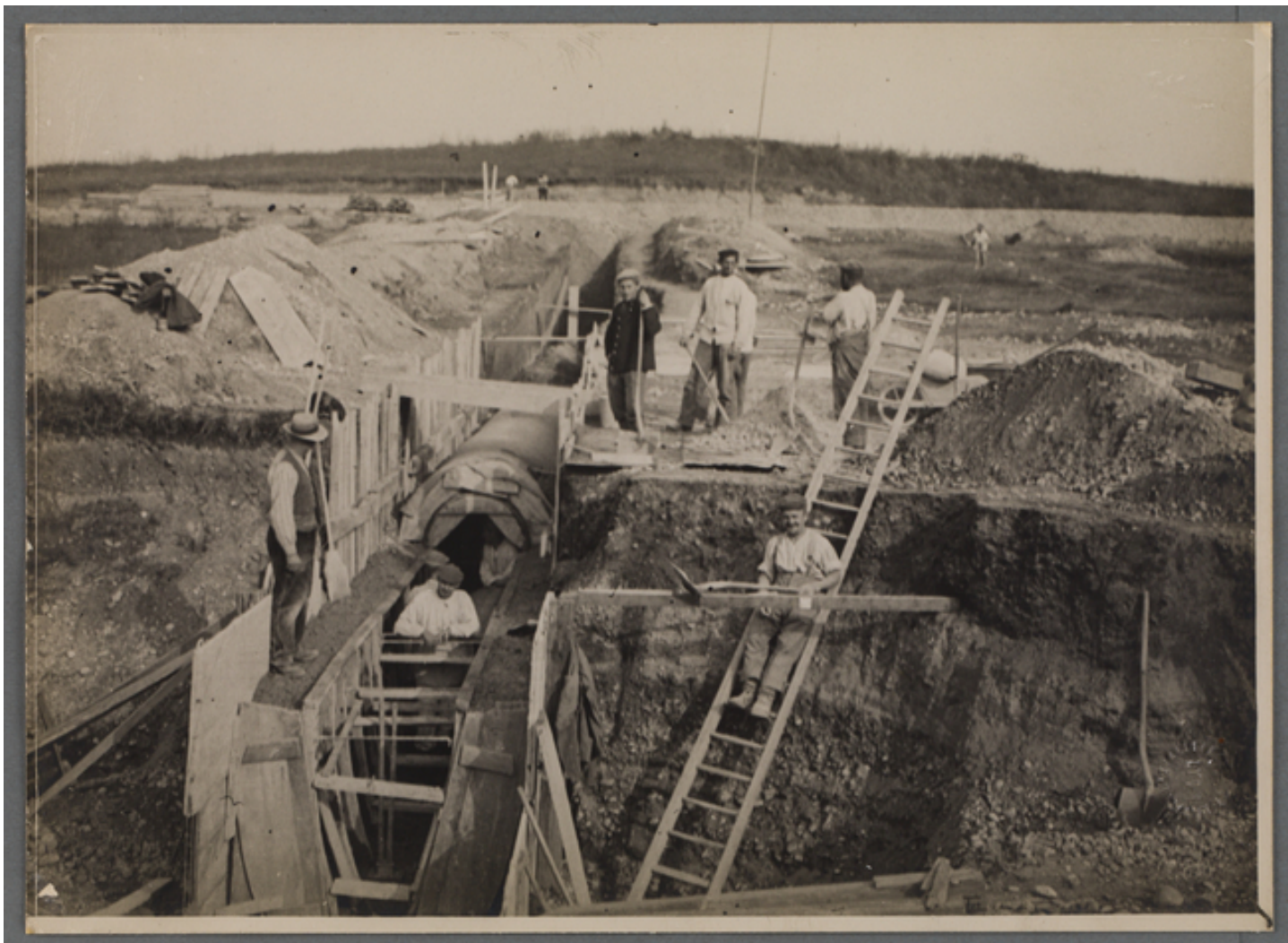
Annexe 4e : Lyon. Hôpital Grange Blanche. Instantané pris sur les chantiers.
