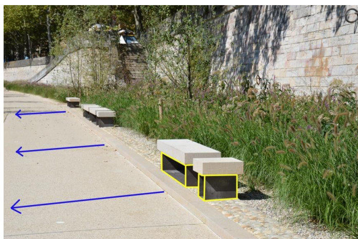
Figure 36 : Positionnement du mobilier en prévention des crues - quai Gillet (2013) – Source : Cap Vert et Stéphanie BIAGGIONI
