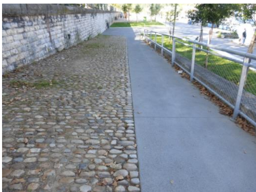
Figure 34 : Rampe de desserte du quai Rambaud (2016) - Source : Stéphanie BIAGGIONI
