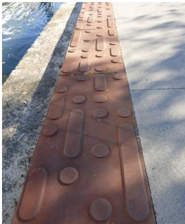
Figure 33 : Les deux types de revêtements choisis pour les bandes d'alertes : en fonte (à gauche) ou en galets (à droite) (2014-2016) - Source : Cap Vert
