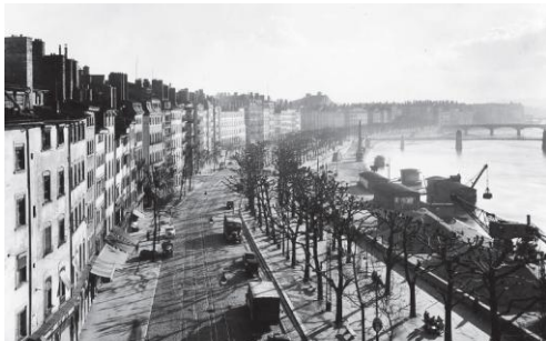
Figure 3 : Délimitation des espaces en ville, chaussée pavée pour les voitures et trottoir pour les piétons (Quai Saint Antoine à Lyon) – Source : Métropole Grand Lyon
