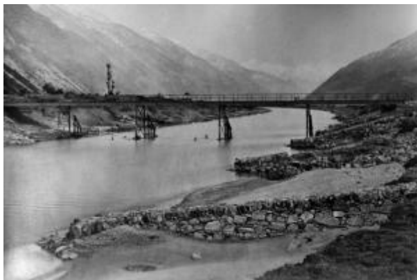
Figure 5 : « Système Girardon » ou endiguement en épi au XIX ème siècle - Source : Aurélie Perret
