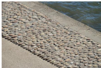
Figure 33 : Les deux types de revêtements choisis pour les bandes d'alertes : en fonte (à gauche) ou en galets (à droite) (2014-2016) - Source : Cap Vert
