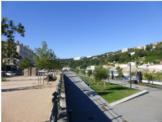
Figure 42 : Plantation de jardinières engazonnées en quai bas du quai Rambaud (2016) - Source : Stéphanie BIAGGIONI
