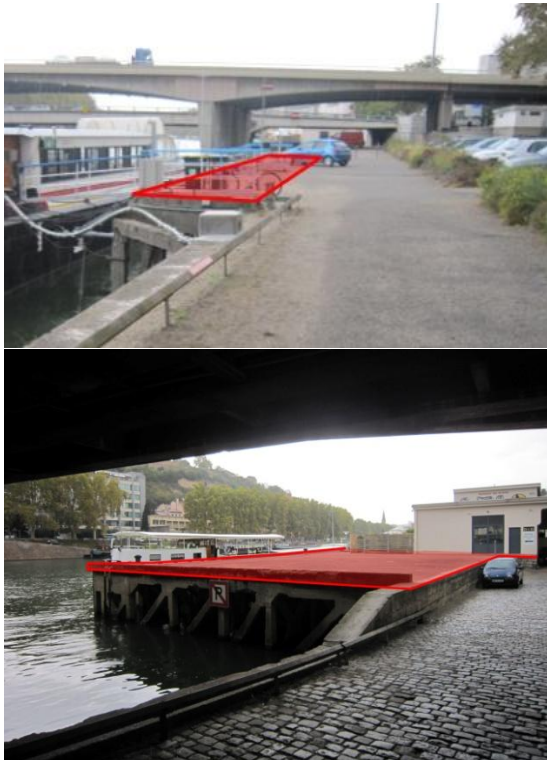
Figure 25 : Estacade 1 à démolir (en haut). Estacade 2 occupée par la boîte de nuit - le POP (en bas) (2016) - Source : Cap Vert
