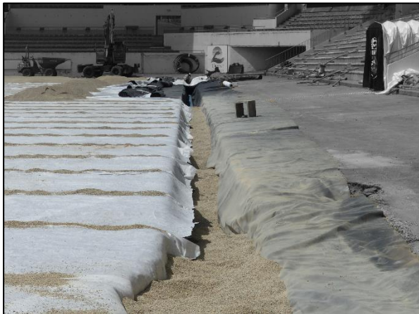
Figure 9 : Réalisation du collecteur périphérique le 25/05/2016, Lorient (auteur : Quentin B.)
