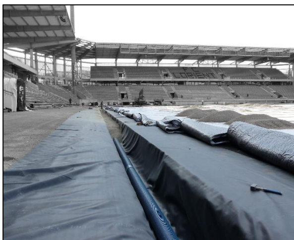
Figure 8 : Mise en place du géocomposite le 25/05/2016, Lorient (auteur : Quentin BRUNOT)
