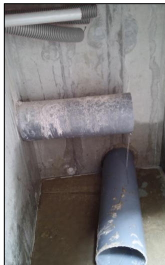
Figure 11 : Connection regard expérimental avec le local technique le 12/07/2016, Lorient le 25/05/2016, Lorient (auteur : Quentin B.)
