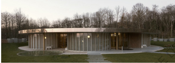
Crématorium de Rennes : livraison 2009
