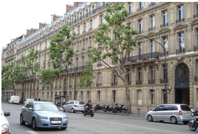
A l'image du boulevard Haussmann à Paris, les rues sont avant tout des espaces techniques, sans lien avec les habitations.
