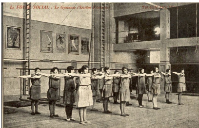
Inauguration du gymnase de la Rotonde en 1926, avec des installations ultra-modernes pour l'époque.
