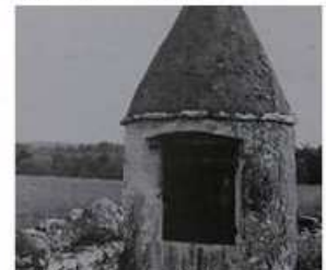
Caselle puit _ Arcambal
