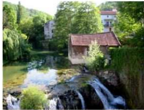
► Moulin à eau à Vers
