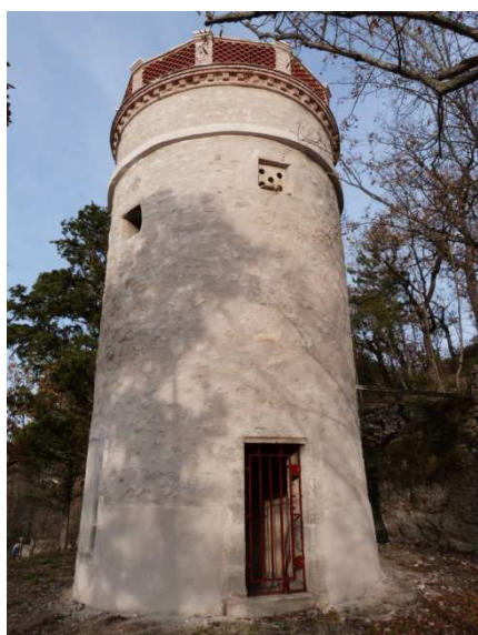
Fig 13 : Pigeonnier à Cahors après travaux de restauration subventionnés par le Fonds Denieul
