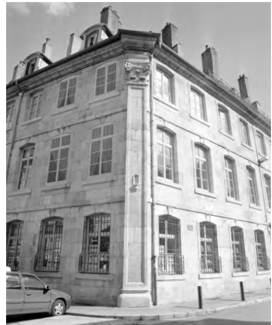
Illustration 32: rue 1 du Lycée (Besançon), un pilastre d'angle compose le coin tronqué. (auteur : Y. Sancey)
