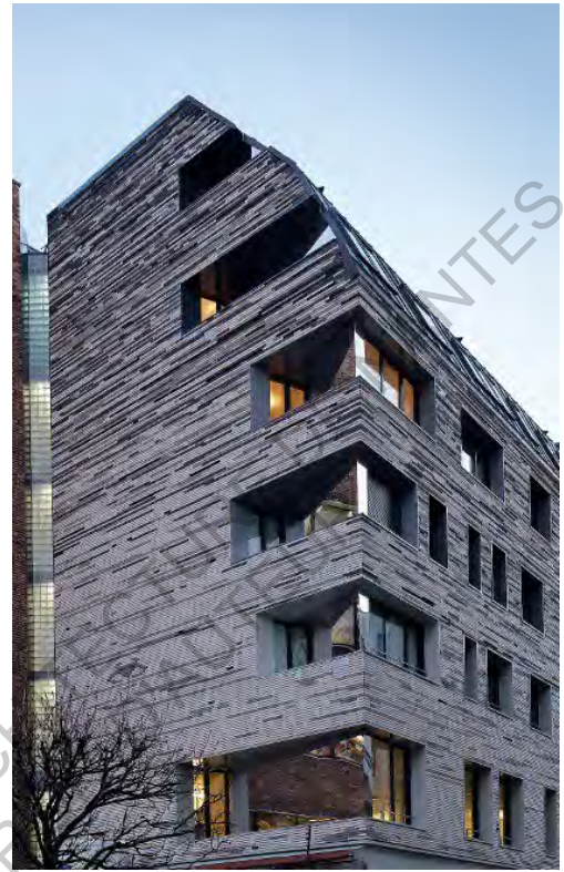
Illustration 30: aujourd'hui, l'angle est libéré des contraintes structurelles du bâtiment, les fenêtres peuvent être beaucoup plus grandes (batiweb.com)
