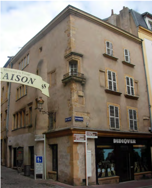
Illustration 29: parce-que les murs porteurs étaient extérieurs, les fenêtres d'angle sont très rares durant la période traditionnelle.
