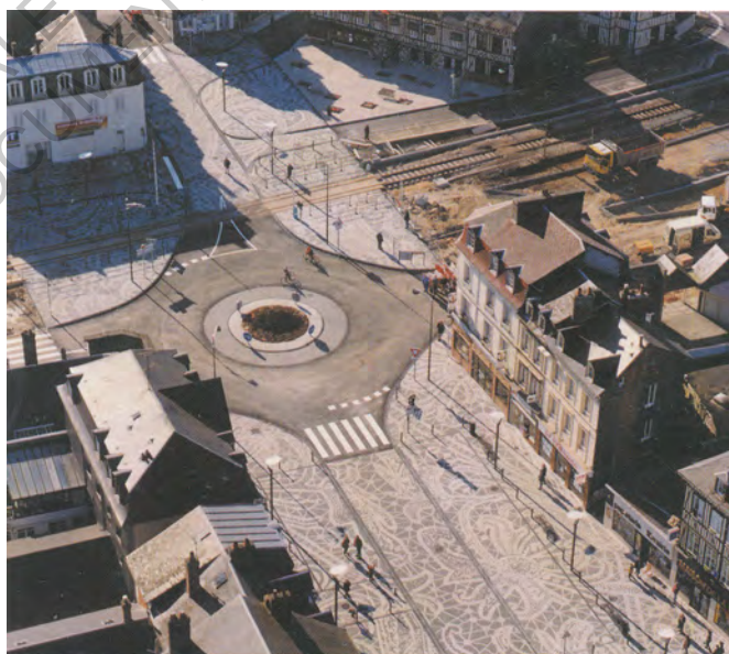
Illustration 51: un rond point accueillant des angles nets (Centre d'études sur les réseaux 2000).
