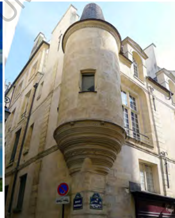
Illustration 19: rue Hautefeuille(Paris), l'hôtel de Fécamp a une tourelle soutenue par un socle "en cul-de-lampe". (Wikipedia)
