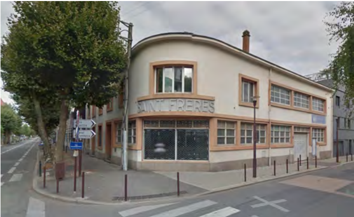
Illustration 25: bâtiment d'angle présentant un pan coupé au rez-de-chaussée et un arrondi à l'étage supérieur. Boulevard de la Prairie au Duc/ Rue Alain Barbe Torte, Nantes.
