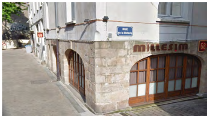
Illustration 24: rues du Vieil Hôpital / de la Bléterie, le coin fut tronqué après l'installation du bâti. Sa présence au rez-de-chaussé uniquement témoigne de sa fonction purement utilitariste.
