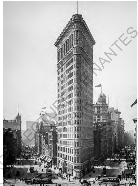
Illustration 4: le FlatIron Building (5th/ Broadway, New York) est de type arrondi aigue. Cette forme et style de bâtiment a été largement recopié, à tel point qu'il constitue un type en soi (un bâtiment de type «flatiron».
