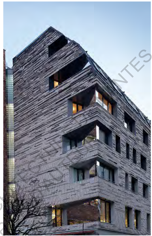
Illustration 30: aujourd'hui, l'angle est libéré des contraintes structurelles du bâtiment, les fenêtres peuvent être beaucoup plus grandes (batiweb.com)
