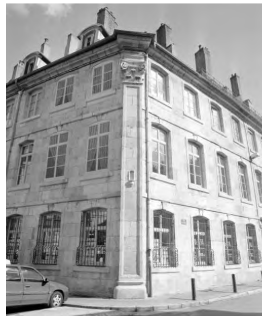
Illustration 32: rue 1 du Lycée (Besançon), un pilastre d'angle compose le coin tronqué. (auteur : Y. Sancey)
