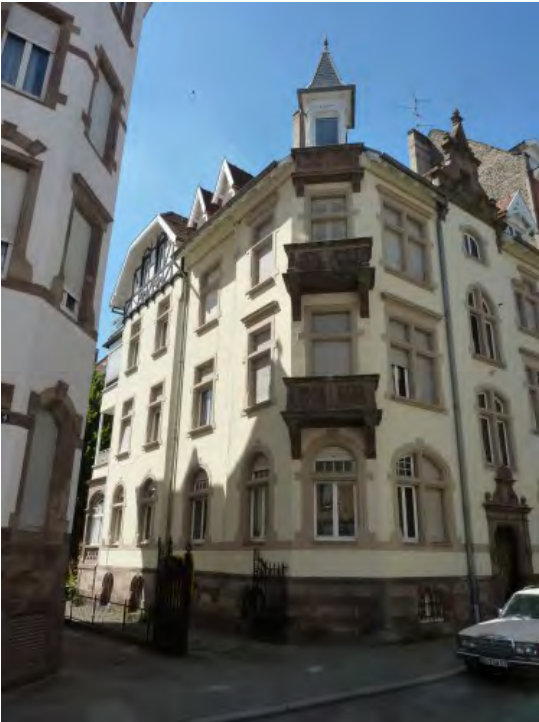
Illustration 21: la tourelle et les balcons d'angle ancrent le bâtiment dans l'intersection. (2 Rue Charles Grad, Strasbourg) (archiwiki.org)
