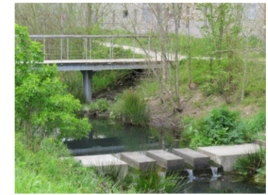
Figure 5 : Noue plantée dans le quartier de la Bottière, Nantes (Bossy, 2016)
