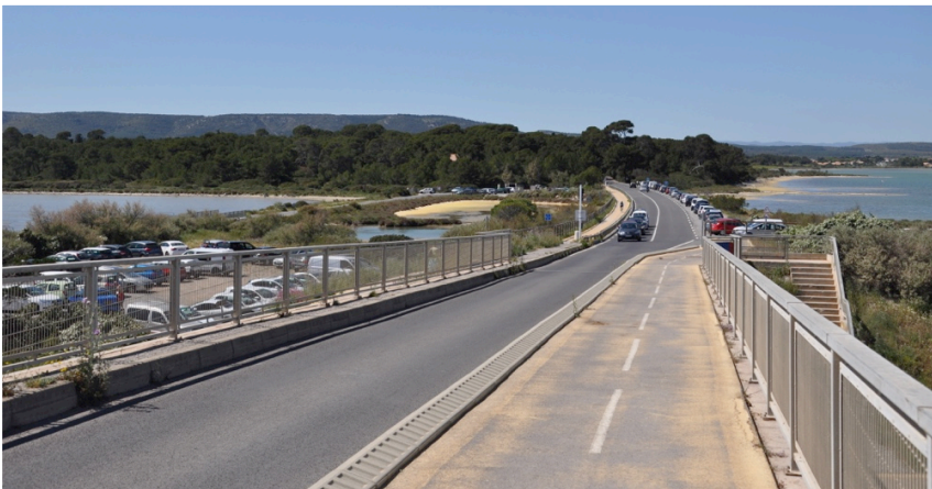
Figure 21 : Vue sur l'espace parking du site et les voies d'accès à la plage, source : Matteudi
