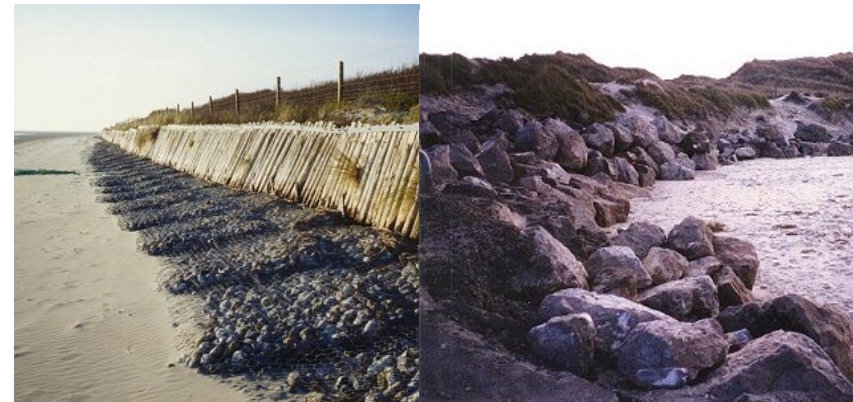
Figure 39: Exemple d'ouvrage longitudinal, source www.u-picardie.fr consulté en 2016
