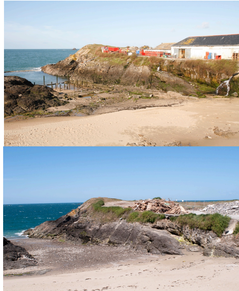
Figure 29: Démolition de bâtiment industriel à la pointe de la Varde (35), source : 1000 paysages en actions 201
