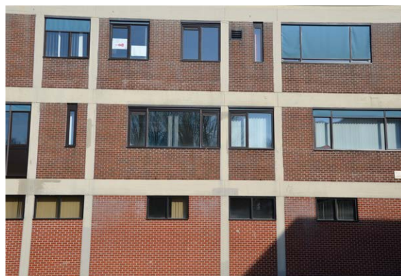
Fig.9. Uniformité de traitement des bâtiments. (Photographie : Bédier, 2016)
