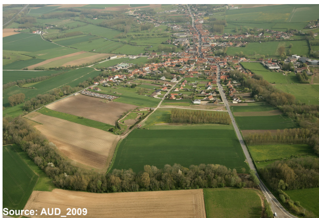
Figure 13. Ancienne enceinte arborée de Théroutanne
