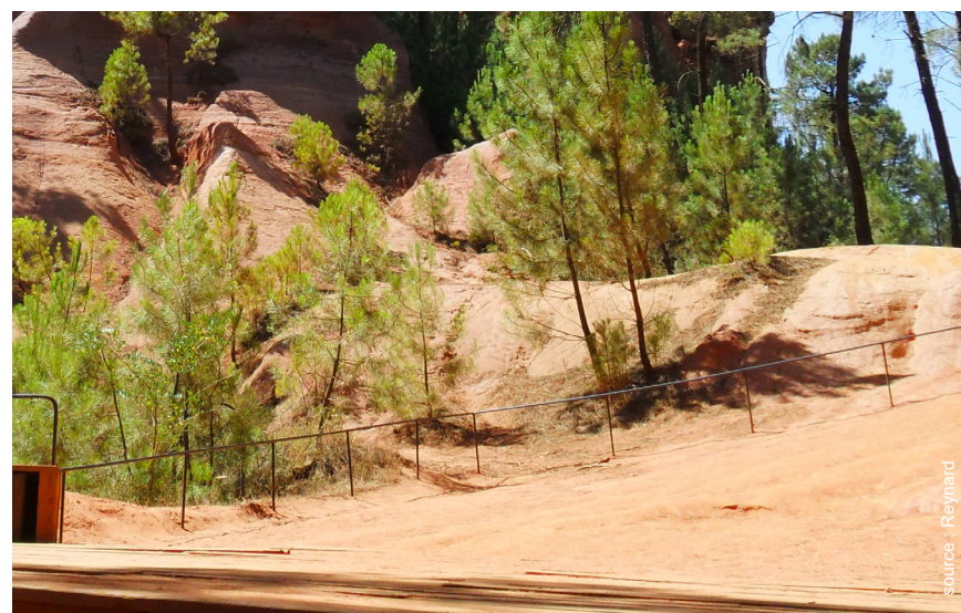
Figure 13. Exemples de garde-corps s'intégrant dans le grand paysage tout en permettant de protéger les milieux des piétinements, 2016
