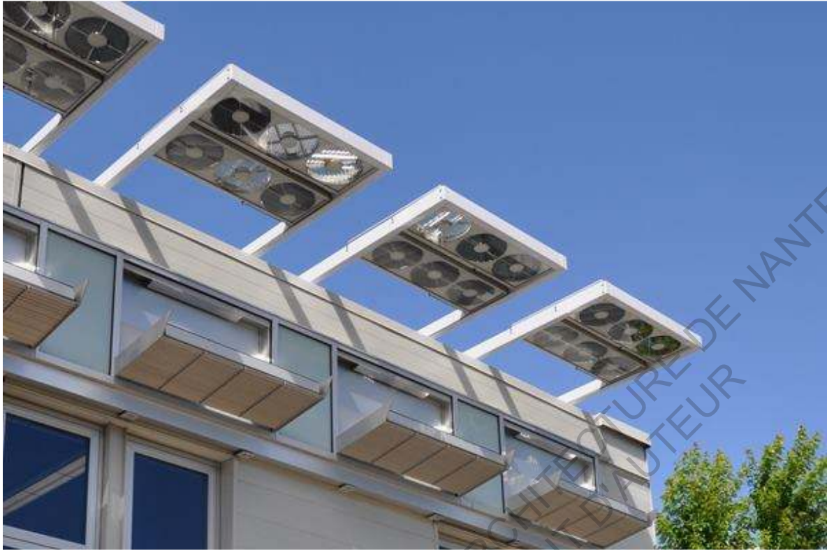
Figure 6-33 Photographie. Capteur de conduit de lumière prismatique. Suncentrale ( www.ecobuildingpulse.com )
