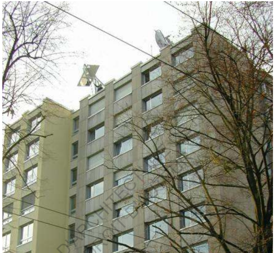
Figure 6-28 Photographie. Capteur de conduit de lumière prismatique. Aspect Paysager. Héliobus (Heliobus.com)
