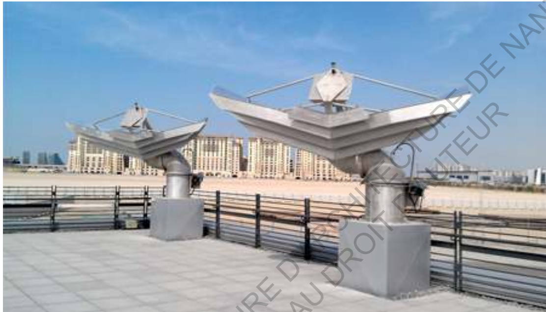
Figure 6-42 Photographie. Capteur de conduit de lumière. Sundolier (Sundolier.com)
