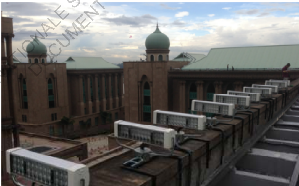
Figure 6-53 Photographie. Capteur de lumiduc à fibre optique. Parans (Parans.com)
