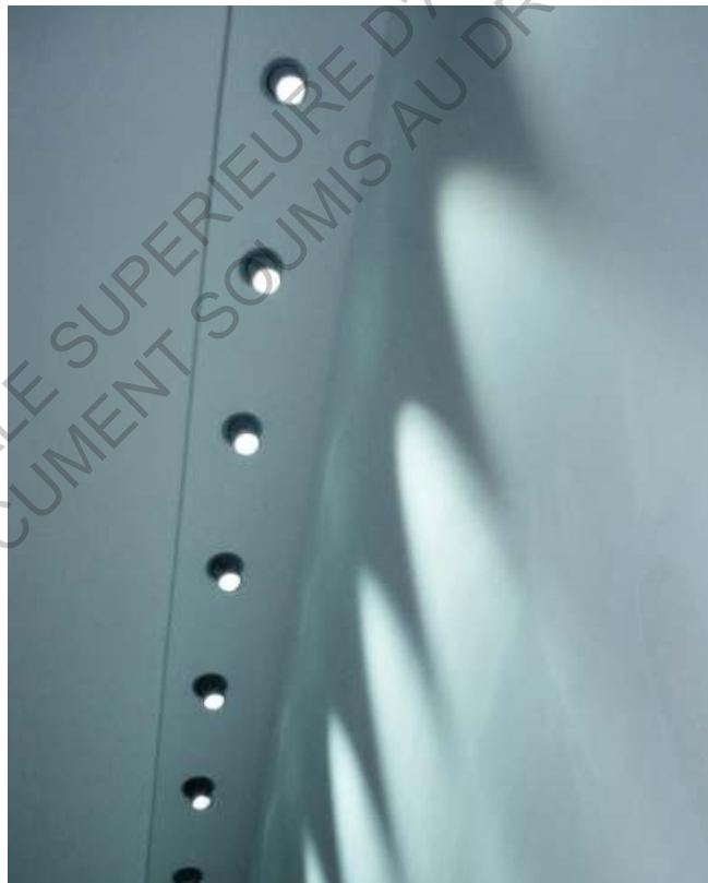
Figure 6-55 Photographie. Diffusion – en spot- des lumiducs à fibre optiques (parans.com)
