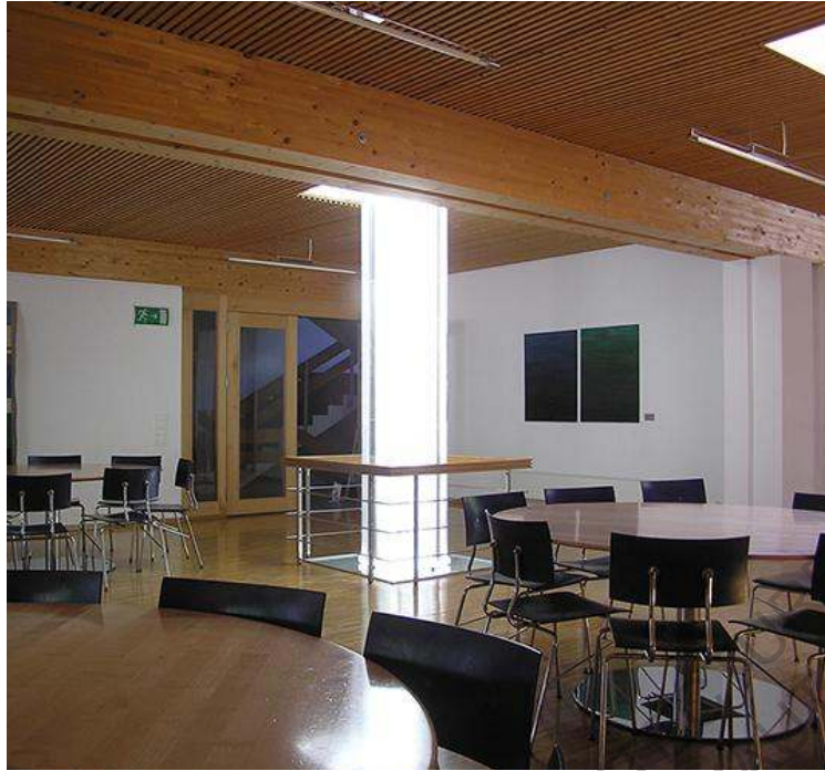
Figure 6-30 Schéma. Photographie. Tube-diffuseur de conduit de lumière prismatique (Heliobus.com)
