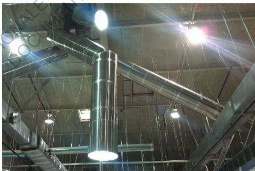
Figure 6-23 Photographie. Tube et diffuseur d'un conduit de lumière métallique (Solatube.com)
