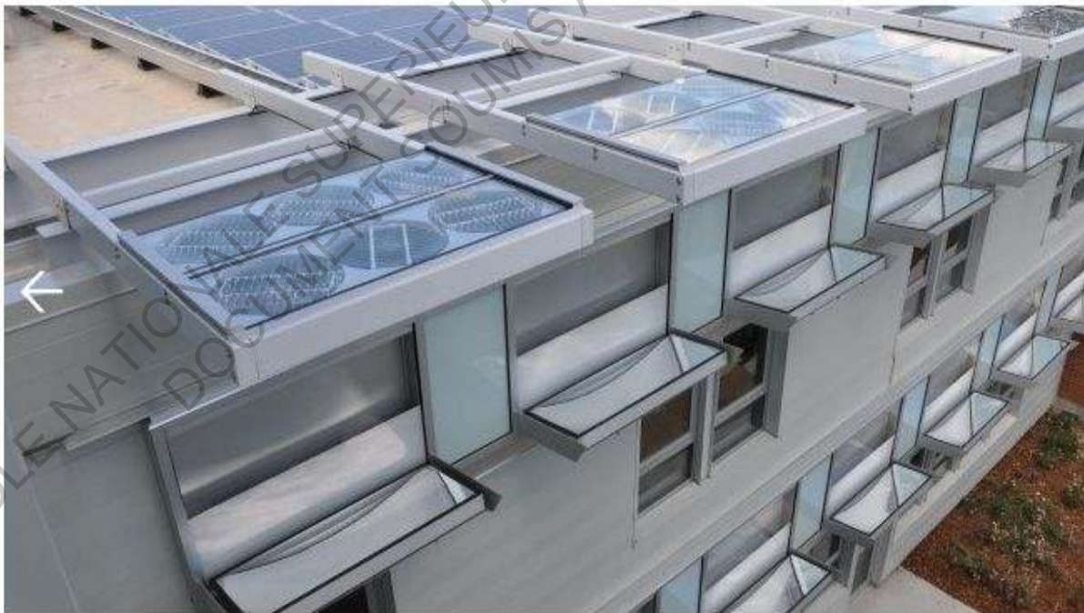
Figure 6-32 Photographie. Capteur de conduit de lumière prismatique. Suncentrale (ecobuildingpulse.com)
