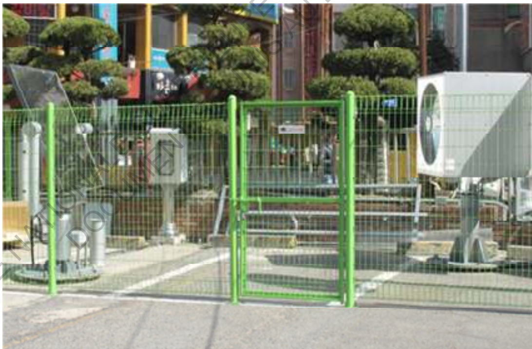
Figure 6-61 Photographie. Dispositif de captage du tunnel de lumière dans l'espace urbain. Sunportal ( thesunportal.com )
