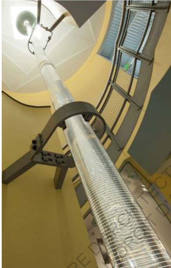
Figure 6-44 Photographie. Diffuseur conduit à tube prismatique. Sundolier (Sundolier.com)
