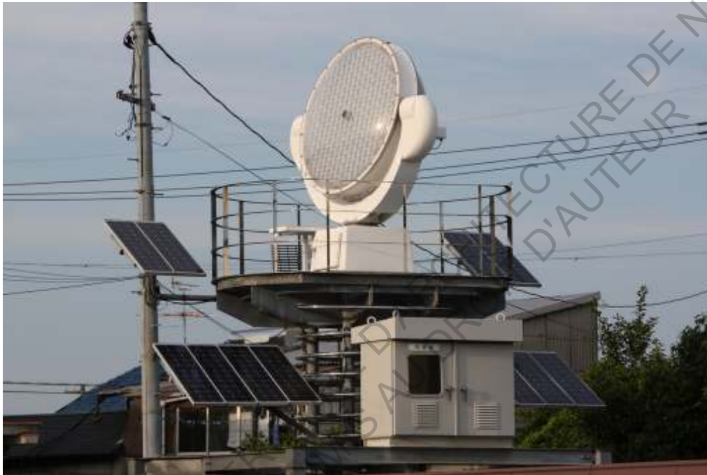
Figure 6-52 Photographie. Capteur de lumiduc à fibre optique. Himawari (Himawari-net.co.jp)
