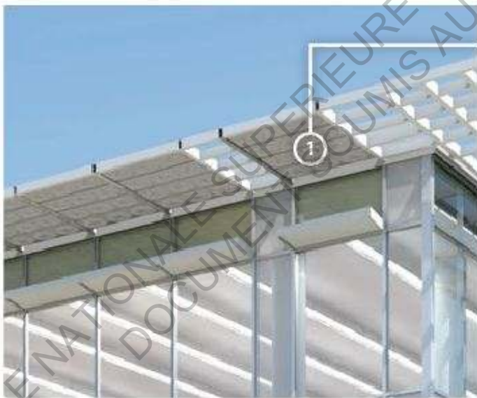
Figure 6-34 Photographie. Capteur collimateur. Suncentrale ( Suncentral.com )
