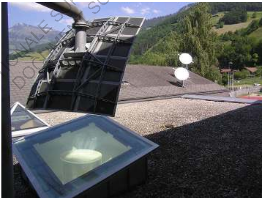
Figure 6-26 Photographie. Capteur de conduit de lumière prismatique. Héliobus (Heliobus.com)
