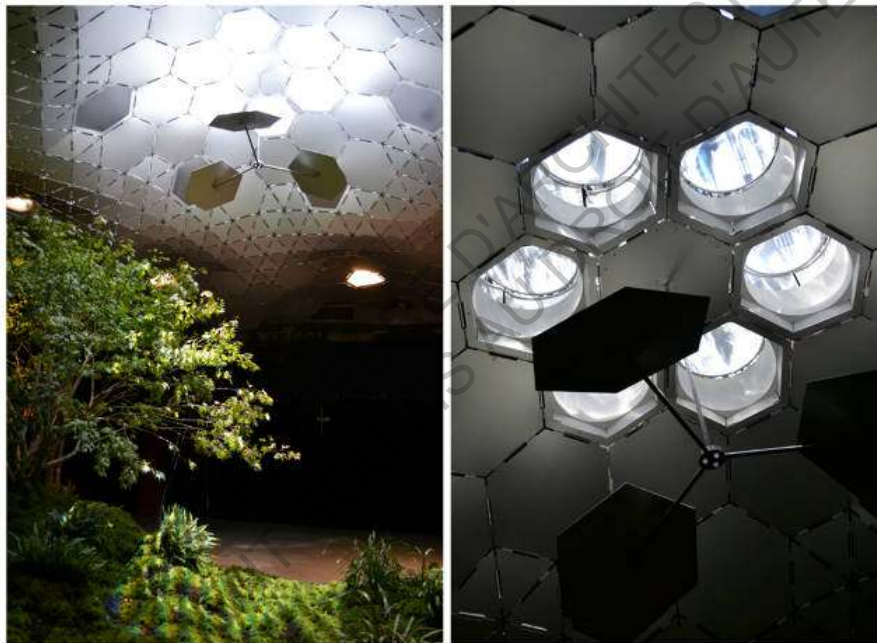
Figure 3-12 Photographies. A droite tube canalisateur. A gauche la Canopée. Low Line NY. (thelowline.org)
