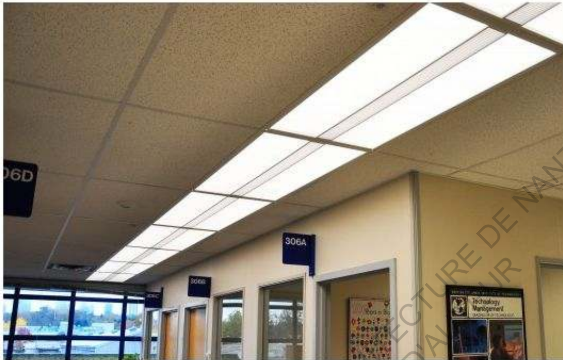
Figure 6-39 Photographie. Tube-diffuseur de conduit de lumière prismatique. Solarcanopy (Rosemann et al, 2007)
